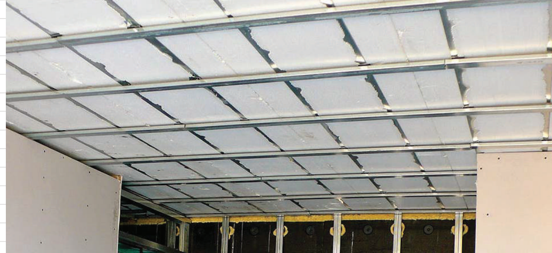
Pomocný rám pre skrutkovanie sadrokartónových dosiek
